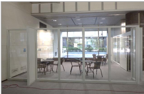
パーティション工事をしました
