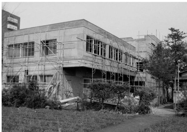
建築中の旧中央図書館（昭和40～41年）
